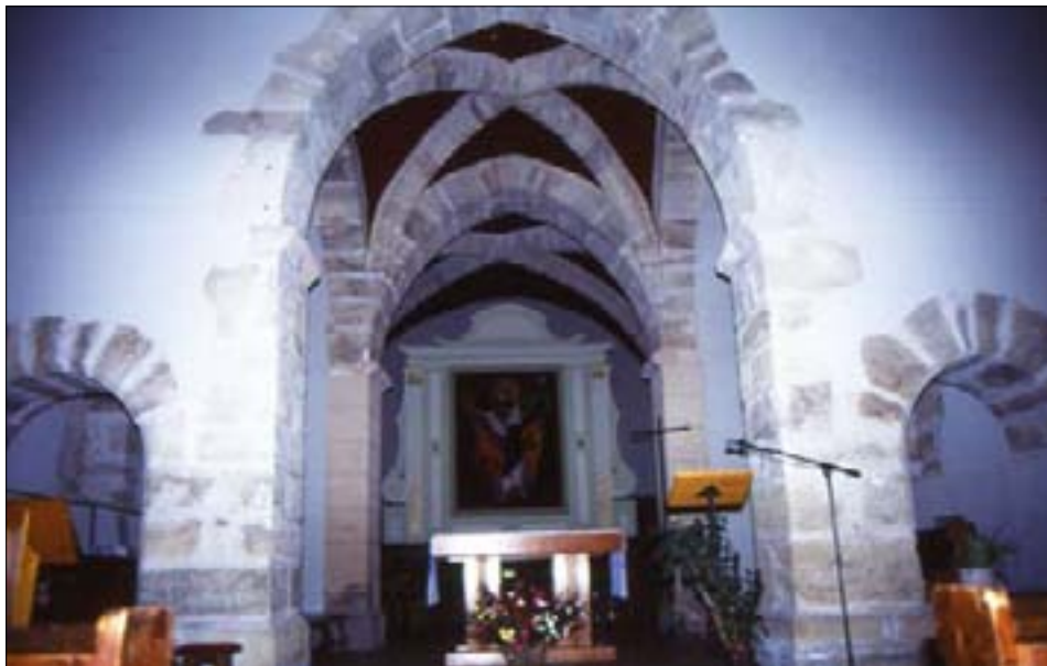
Fig. 19 - Le chœur et le transept de l'église du Breuil avant les travaux de 2009.
